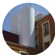
SILOS Y DEPÓSITOS
